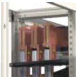
Conexión del juego de barras horizontal.
