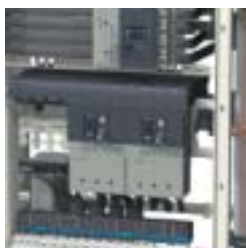
Repartidor Polypact para 3 interruptores Compact NS250.
