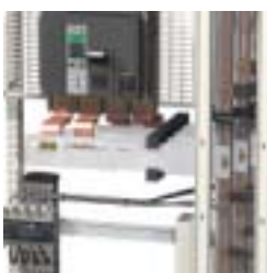
Conexión del juego de barras horizontal.
