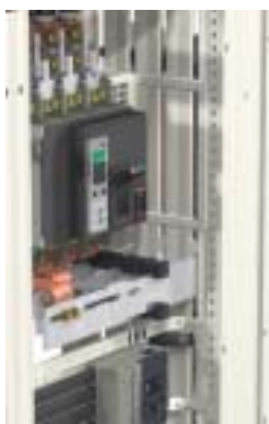
Pantalla Forma 2, en toda la altura del tablero con perforaciones para el paso de las conexiones.
